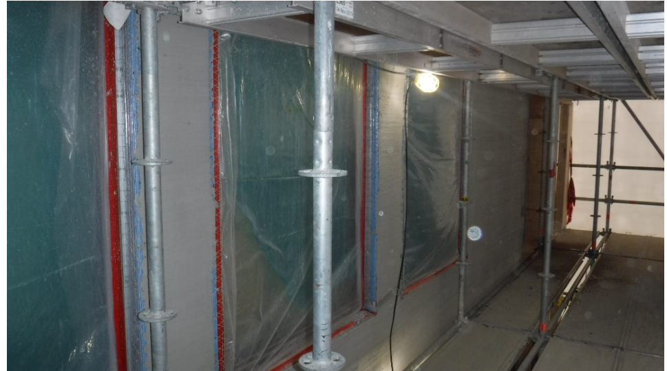
Stucco Scratch Coat
