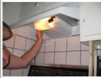
Photo n° 4: Obturation de l'extracteur d'air de la cuisinière
