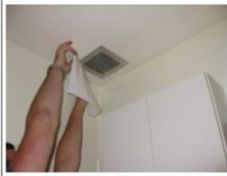
Photo n° 5: Obturation de l'extracteur d'air de la salle de bain
