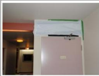
Photo n° 6: Obturation des grilles d'apport d'air dans les corridors
