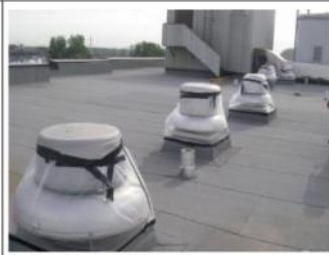
Photo n° 7: Obturation des extracteurs d'air au toit
